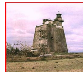
Torre del Faro di Scanzano (Mt)
